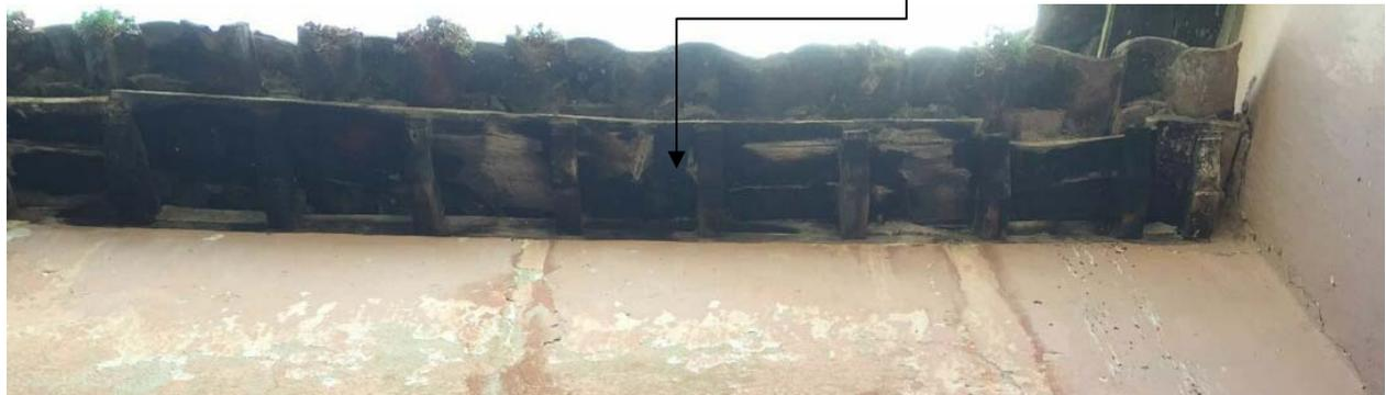
El cuerpo del fondo es el más deteriorado. Seguramente la cubierta, a un solo agua hacia el "rodadero", es una reparación o modificación del modelo original. Este forjado de cubierta se ha desplomado en la zona derecha.
