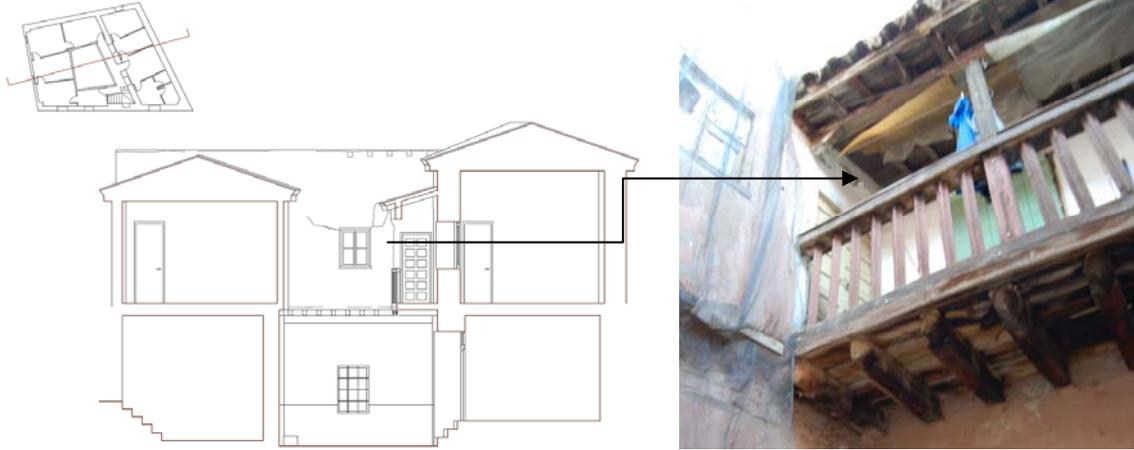
En la planta baja se observa un alfarje sencillo apoyado en un muro coronado por una viga de madera que continúa paralelo al muro del fondo. Tiene una zona deteriorada, fruto de la entrada de agua derivada del colapso superior.
